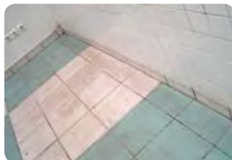
Ici les parois horizontales et verticales sont colonisées.
